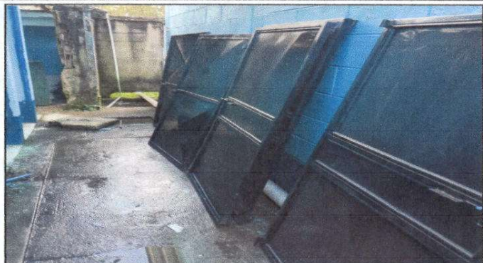
Foto1: Dando mantenimiento a estructura (lijado, cambio de tubo, cepillado sujecion, aplicación de pintura puertas de baños) 98 x 180 mts2
