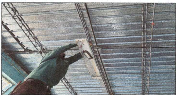
Foto 5: Sistema eléctrico: Cambiando la Iluminación.
