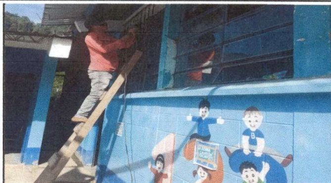
Foto 2: Cambiando vidrios quebrados. Colocando balcones de metal
